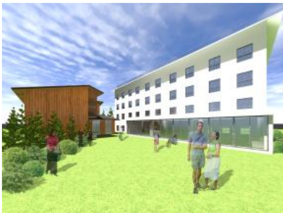
庭から見た完成予想図：新研究者棟(木造 2 階建)と旧本館(鉄筋 4 階建)
